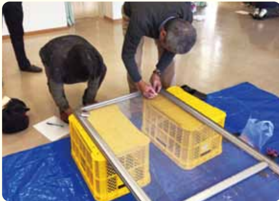
網戸の張り替え作業中
